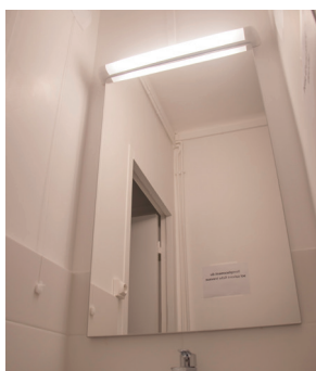
Réfection des salles d'eau de logements sociaux à Paris 14ème.
