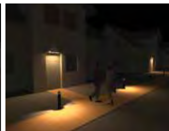
Cheminement extérieur allumé si une présence est détectée
